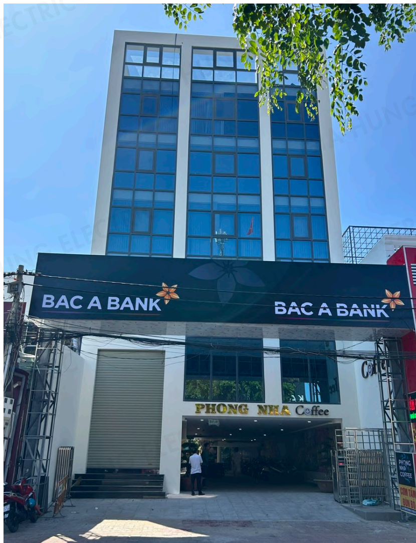
Trụ sở Ngân hàng - 492 Trương Công Định - Vũng Tàu Bank Headquarters - 492 Truong Cong Dinh Street, Vung Tau
